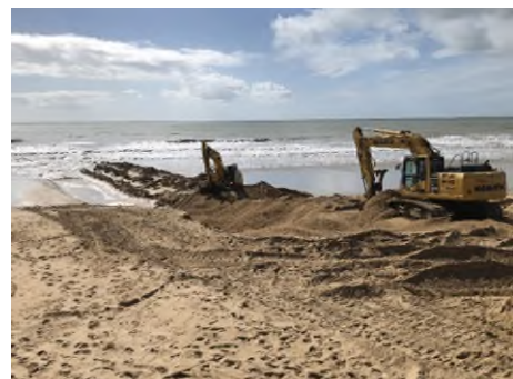
Photo : Lutte contre l'érosion pour l'atterrage du câble marin DUNANT sur la plage de Saint-Hilaire de Riez (France) source : https://merceron.com/
